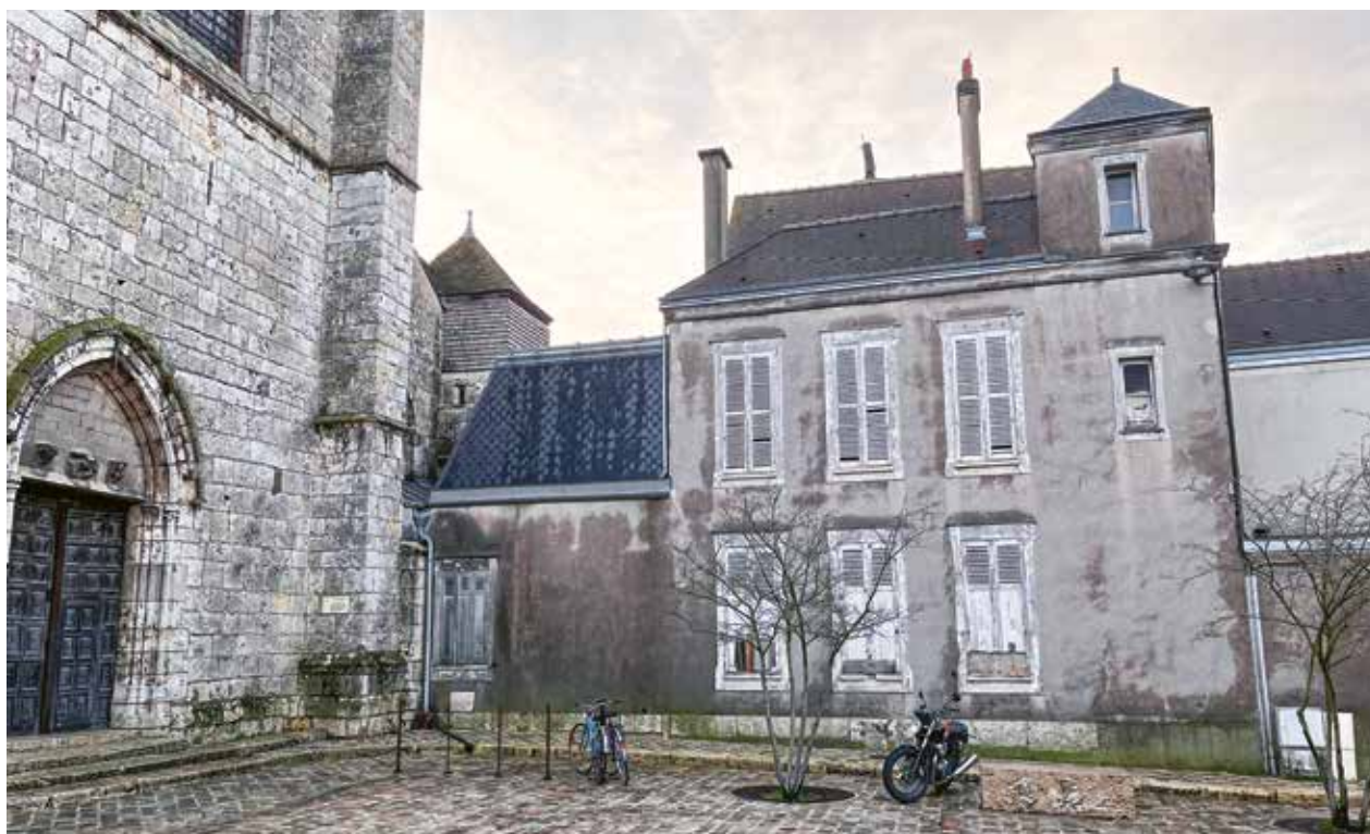
Une ORI prioritaire : un immeuble de 241 m 2 habitables, place Saint-Aignan.
