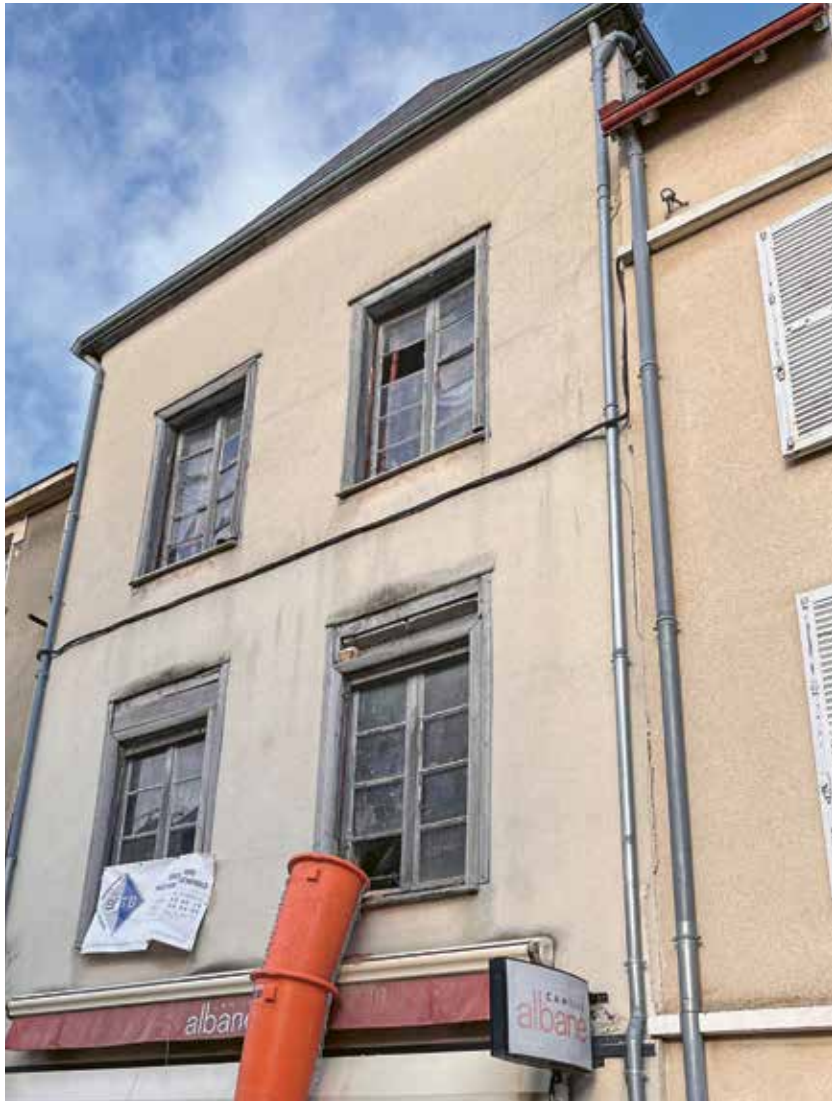
Une ORI en cours au 4, rue de la Volaille.
