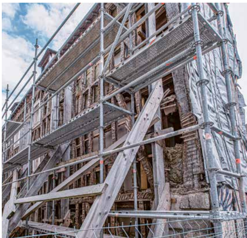
| L'immeuble mis à nu au tout début des travaux.
