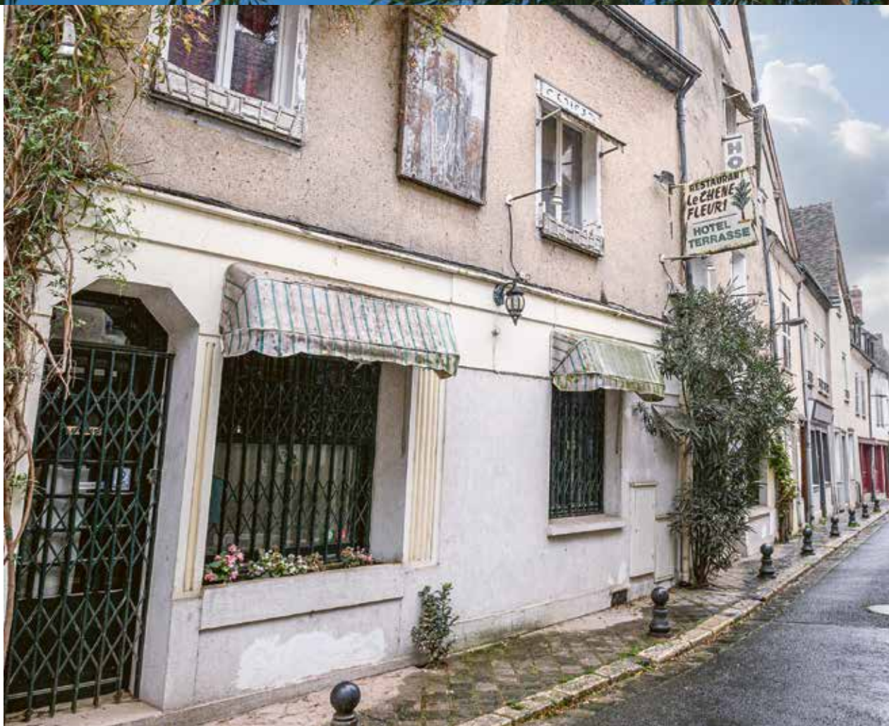
L'immeuble Chêne-Fleuri, au 14, rue de la porte Morard : un projet de réhabilitation de trois bâtiments.
