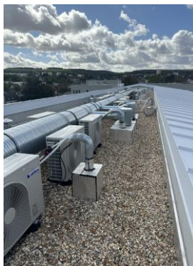
PAC Air/Eau (Chauffage, ECS (et froid))
