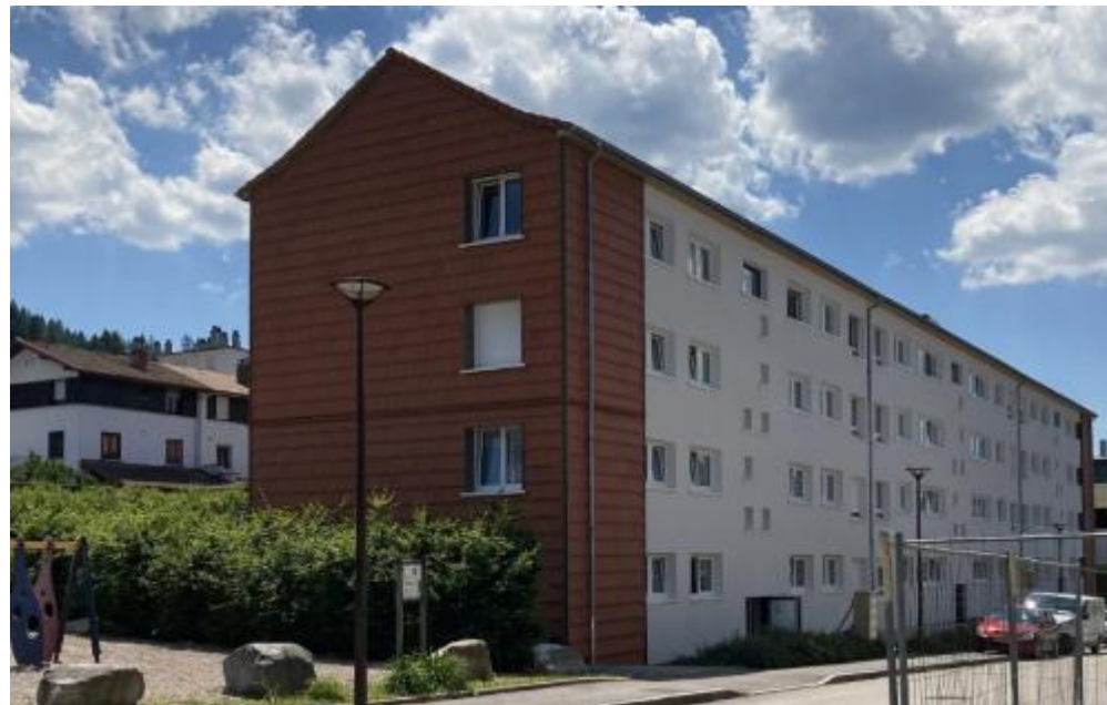
40 logements, rénovation passive Chaudière fioul → 3 PAC collectives de 35kW
