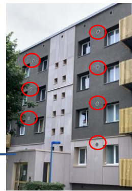
PAC Air extrait/Eau (Chauffage, ECS (et froid))
