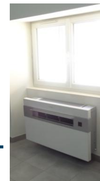
PAC Air/Air monobloc (Chauffage et froid)
