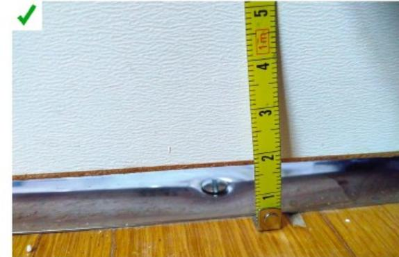
Le détalonnage de la porte de la cuisine est de 2 cm, conformément aux règles de l'art. ©ADQC
