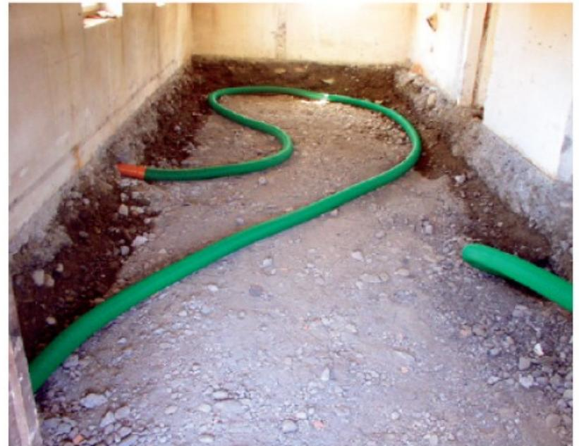
Rénovation de la structure sous le plancher : pose d'un système de drainage du radon
