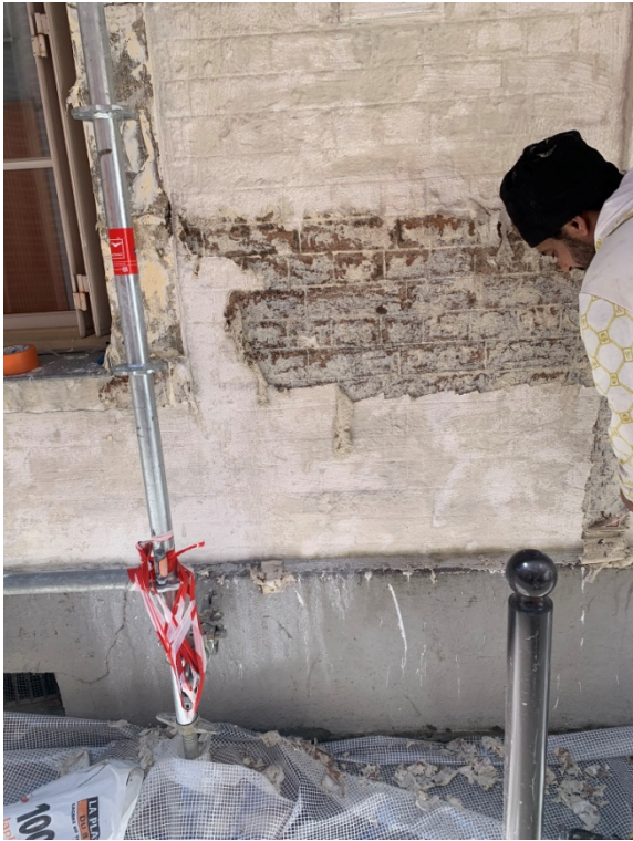
Piochage ancien revêtement
