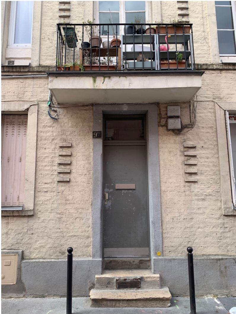
Porte accès rue avant travaux
