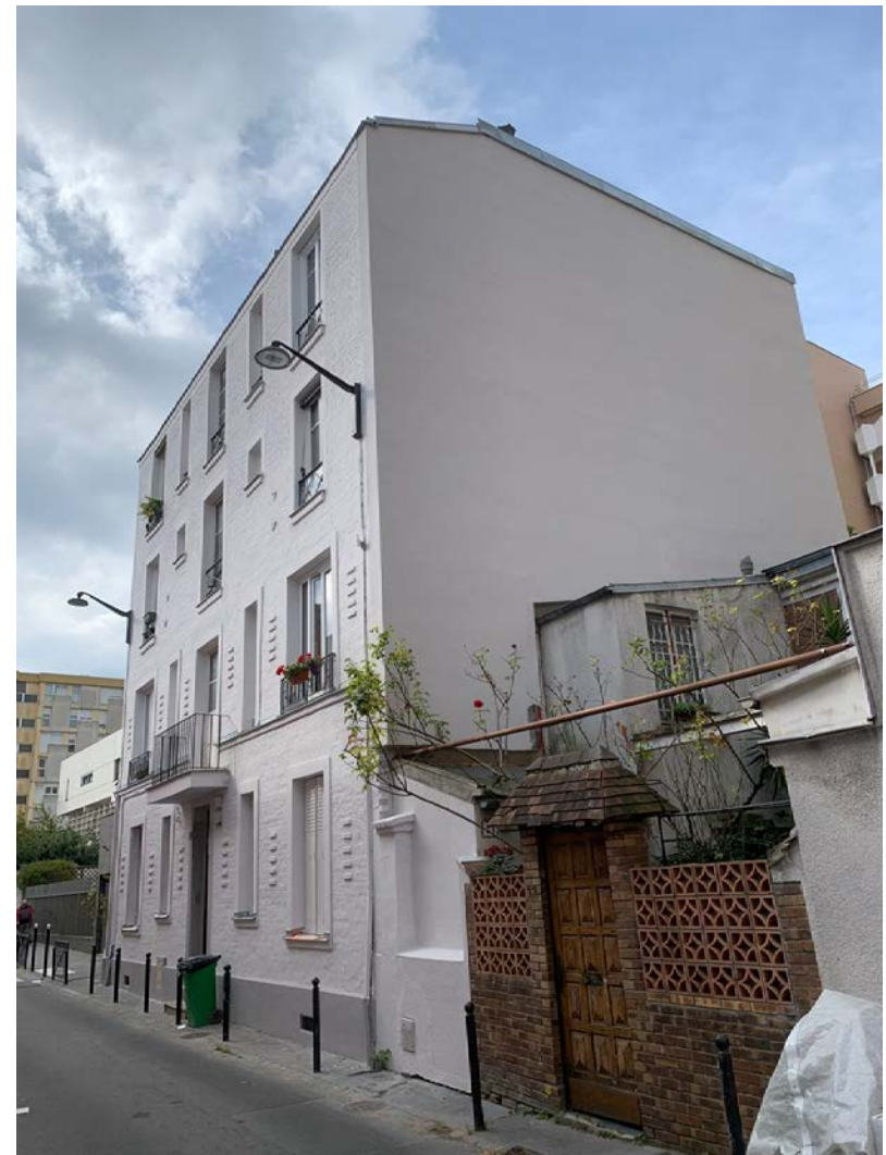
Façade sur rue après travaux
