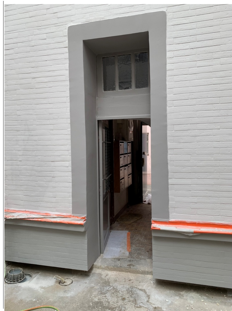
Porte accès cour après travaux
