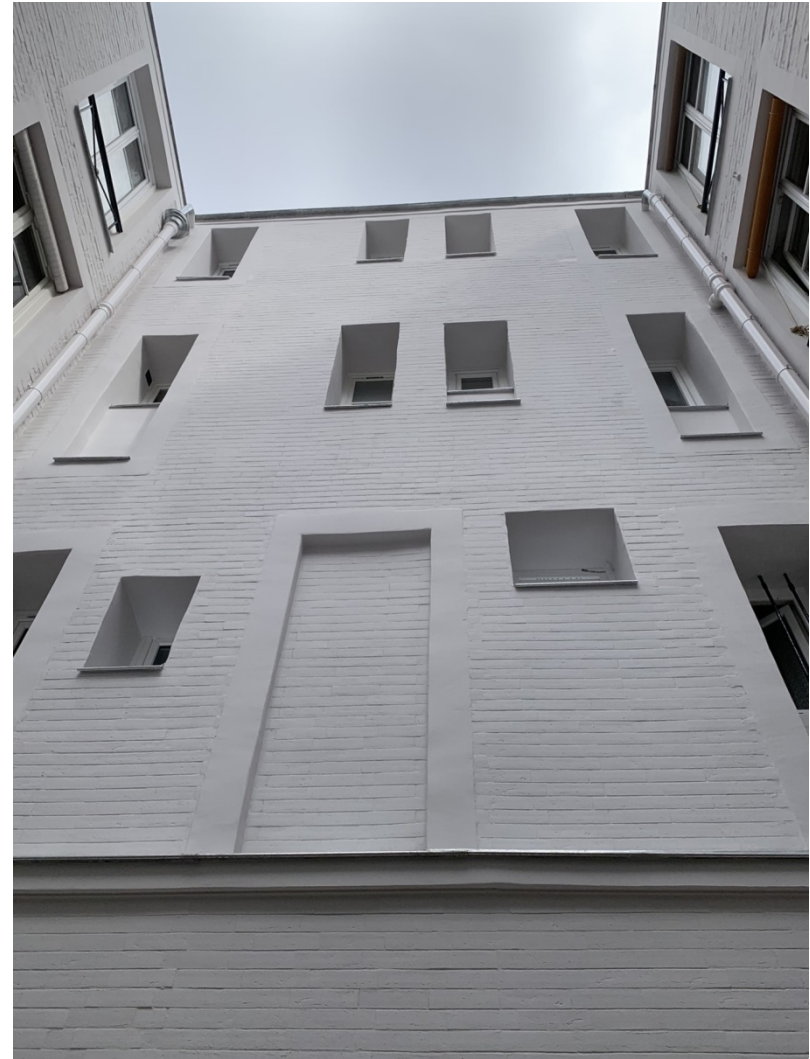
Façade cour après travaux
