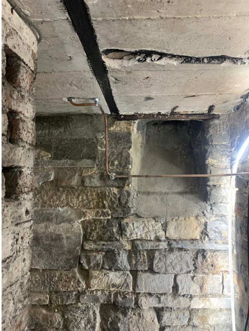
Plancher haut caves avant travaux
