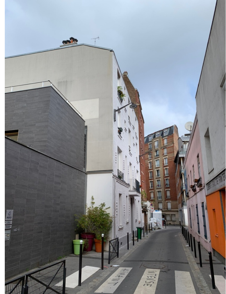
Façade sur rue après travaux
