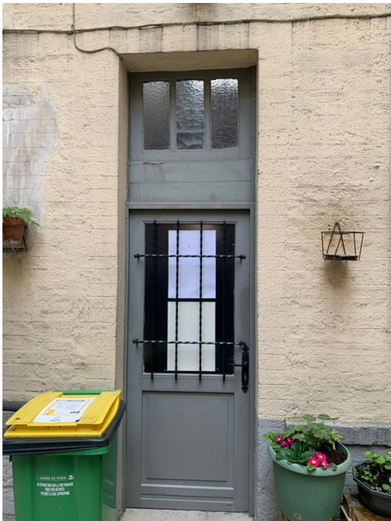
Porte accès cour avant travaux
