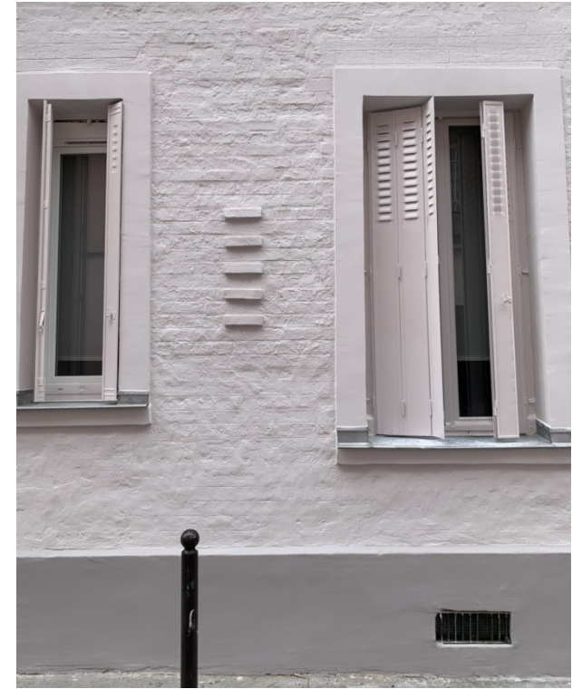
Mise en peinture minérale de la façade brique
