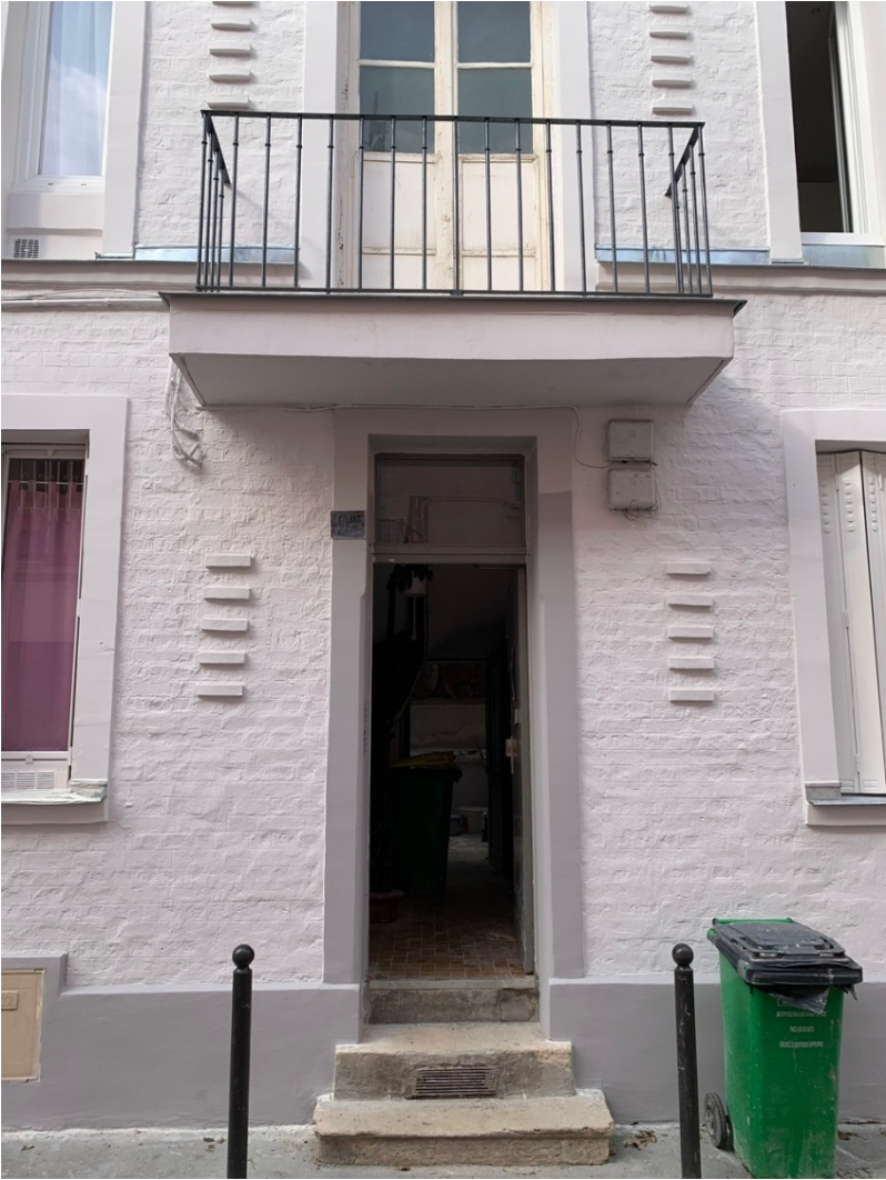
Porte accès rue après travaux
