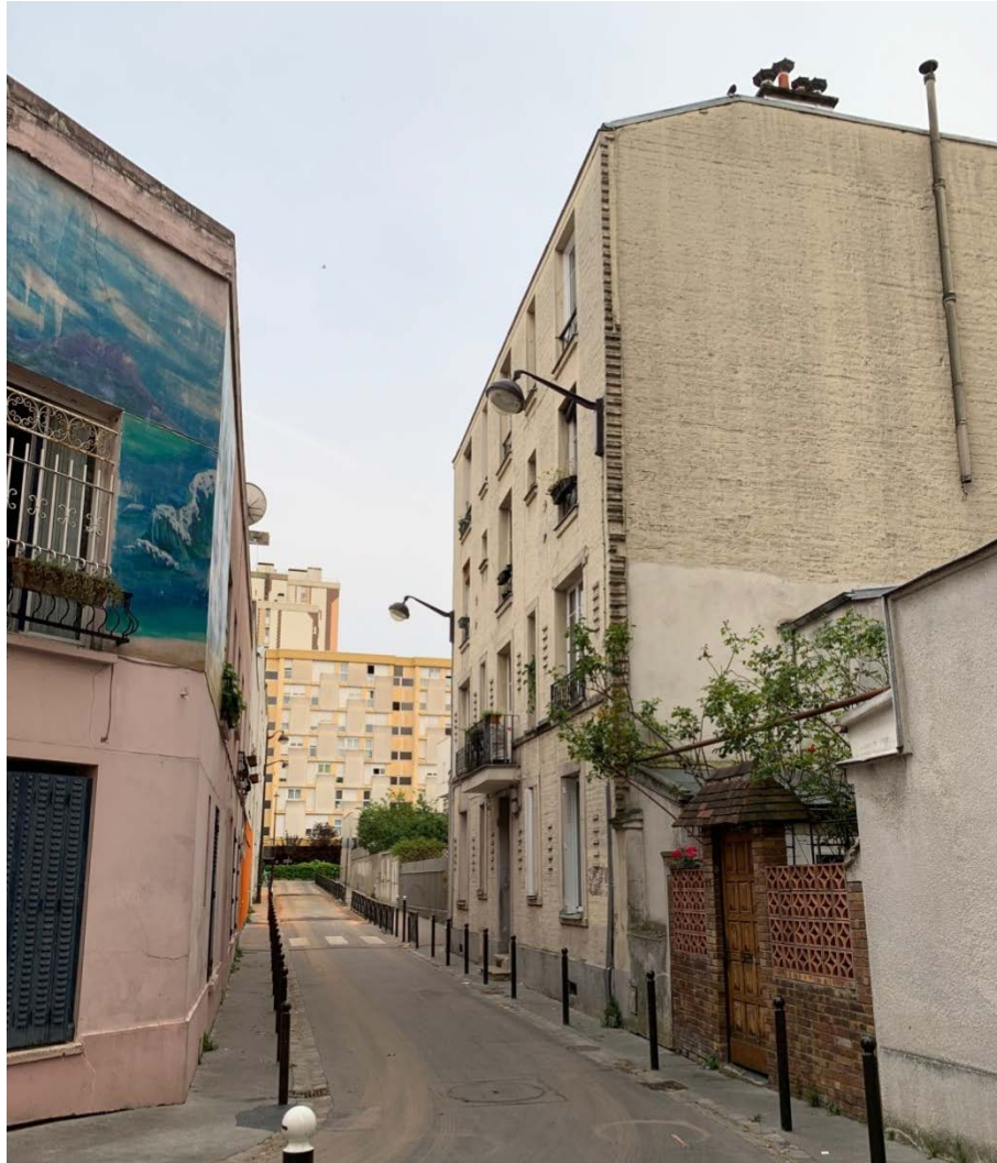
Façade sur rue avant travaux
