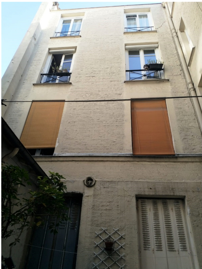
Façade cour avant travaux
