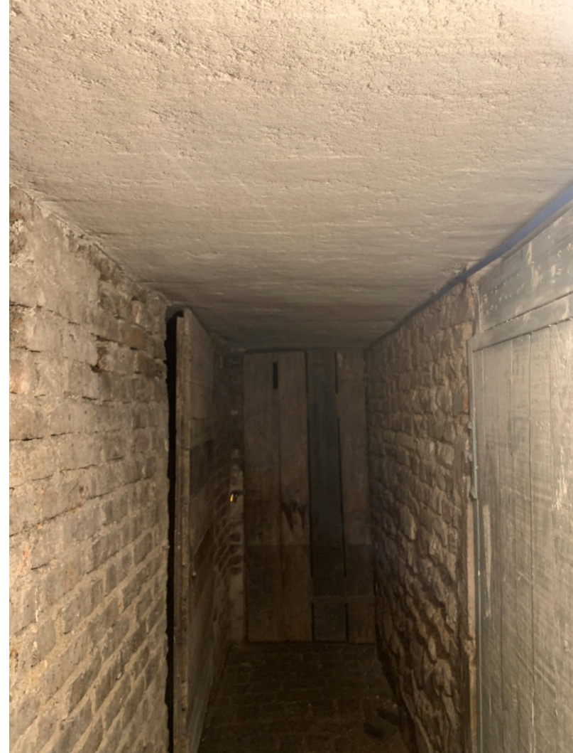
Isolation plancher haut des caves – enduit fibreux Isotherm 20 cm
