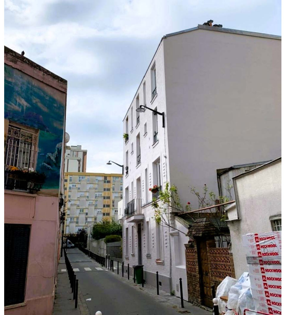
Façade sur rue après travaux
