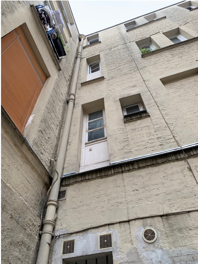
Façade cour avant travaux
