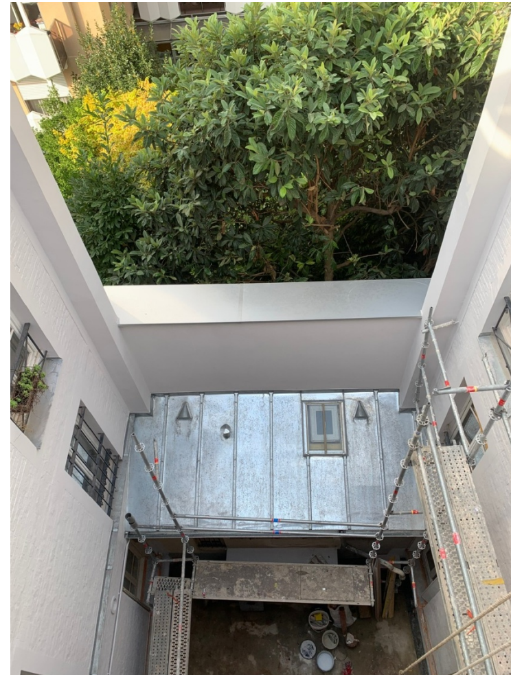
Façades cour et couverture appentis après travaux
