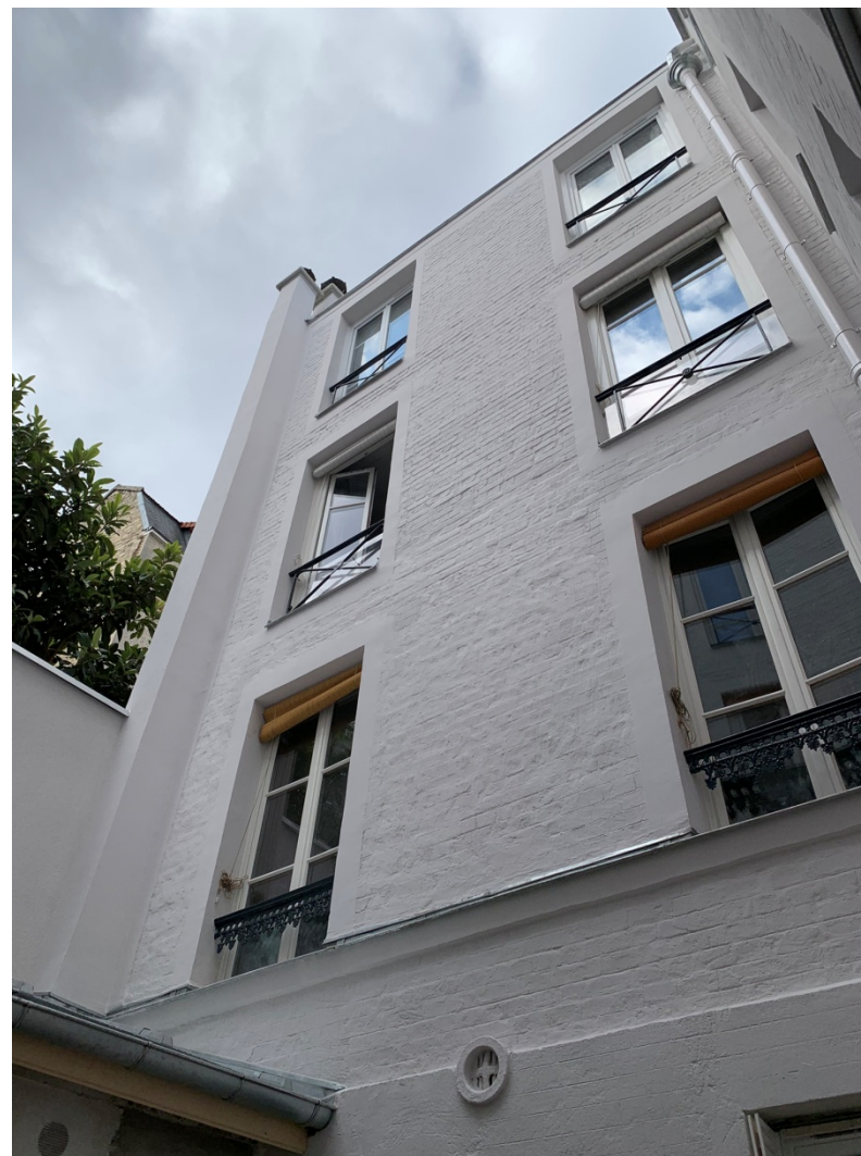
Façade cour après travaux
