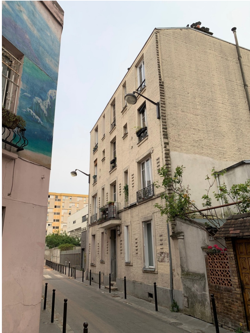
Façade sur rue avant travaux
