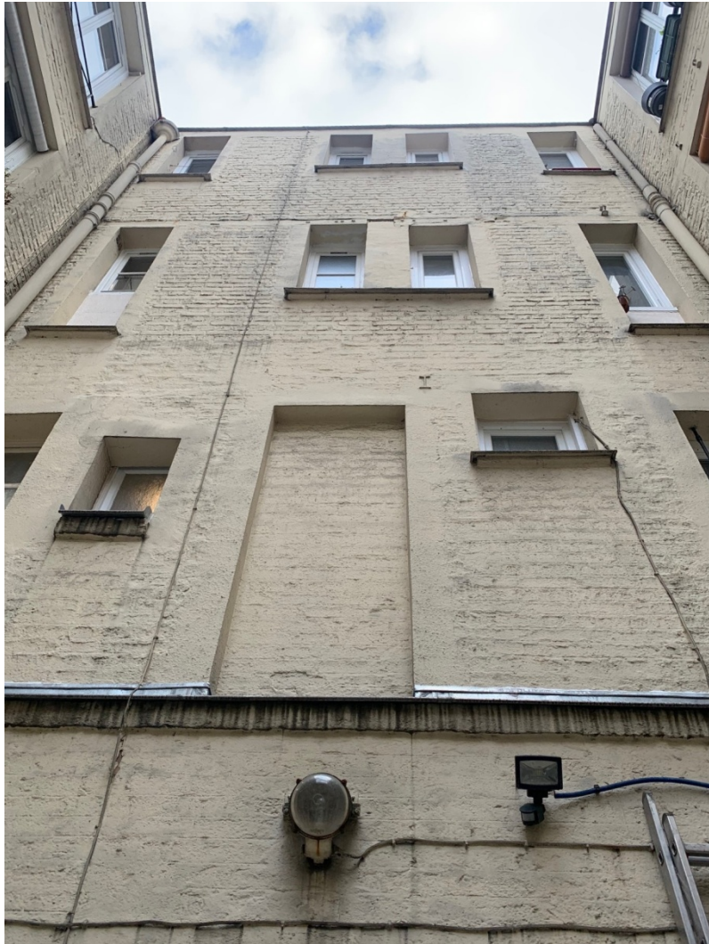
Façade cour avant travaux
