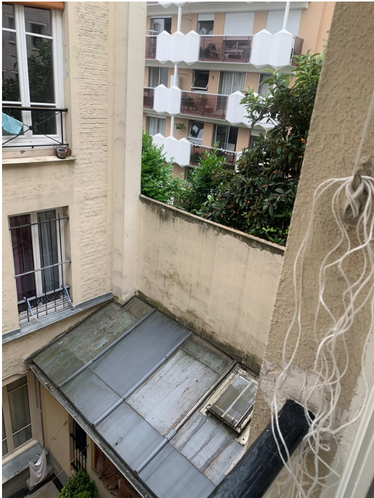
Façades cour et couverture appentis avant travaux
