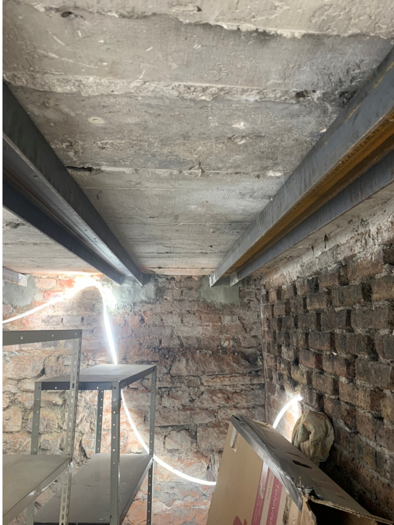
Travaux caves – renforcement PH par des poutres IPN
