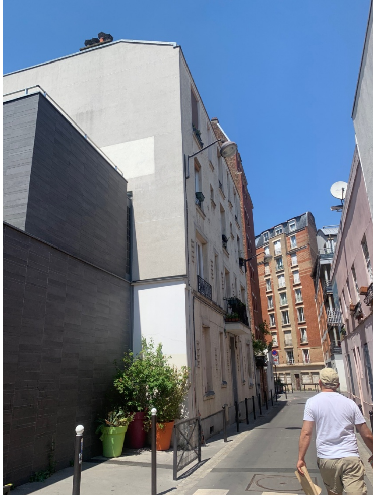
Façade sur rue avant travaux
