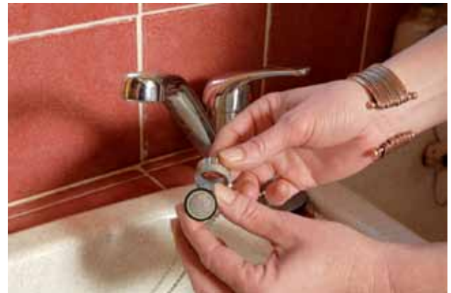
Certains aérateurs ou réducteurs de débit permettent de diminuer sensiblement le débit d'un robinet standard, avec le même confort d'utilisation.
