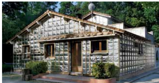
Isolation d'une maison par l'extérieur. L'isolant sera recouvert d'un parement.
