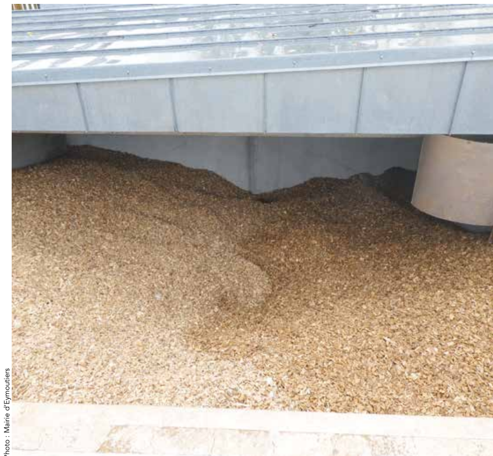
◀ Silo de stockage de plaquettes forestières au pied d'un bâtiment de logements d'Eymoutiers, chauffé au bois.
