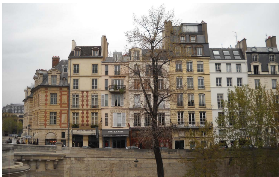
Bâtiments surélevés façade sud du lotissement de la place Dauphine, Paris 1 er
