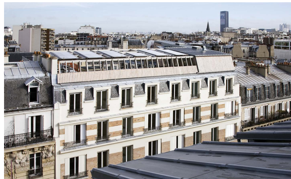
Immeuble réhabilité et surélévé d'un étage avec pose de capteurs solaires, Paris 15 e
