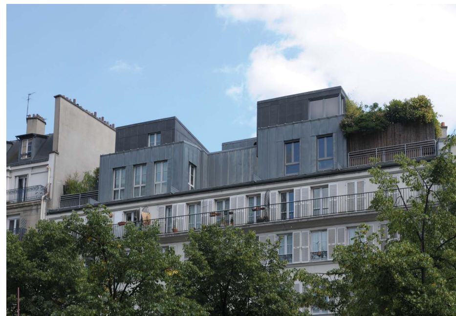
Logements créés par surélévation d'un immeuble de type faubourien, avec végétalisation des terrasses, Paris 19 e
