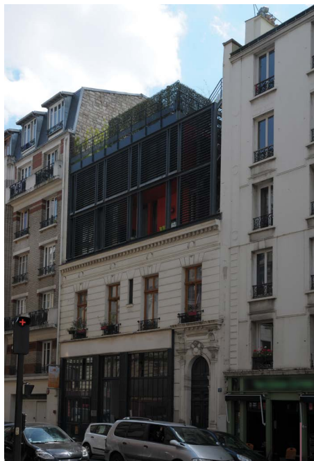
Surélévation d'un logement à ossature métallique, Paris 11 e
