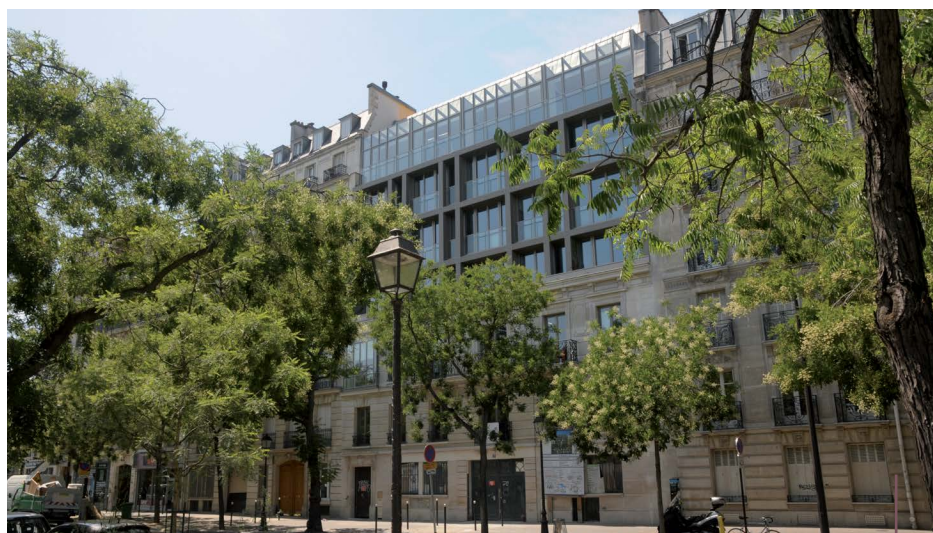
Restructuration et surélévation haute qualité environnementale (HQE) d'un hôtel particulier, Paris 4 e
