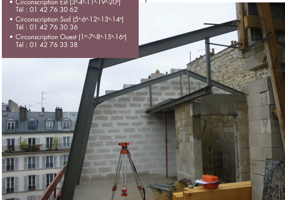
Chantier de surélévation, Paris 11 e
