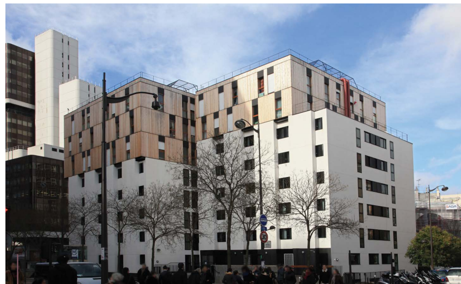
Rue de Tolbiac, Paris 13 e - Surélévation de 3 niveaux à structure bois d'une résidence sociale
