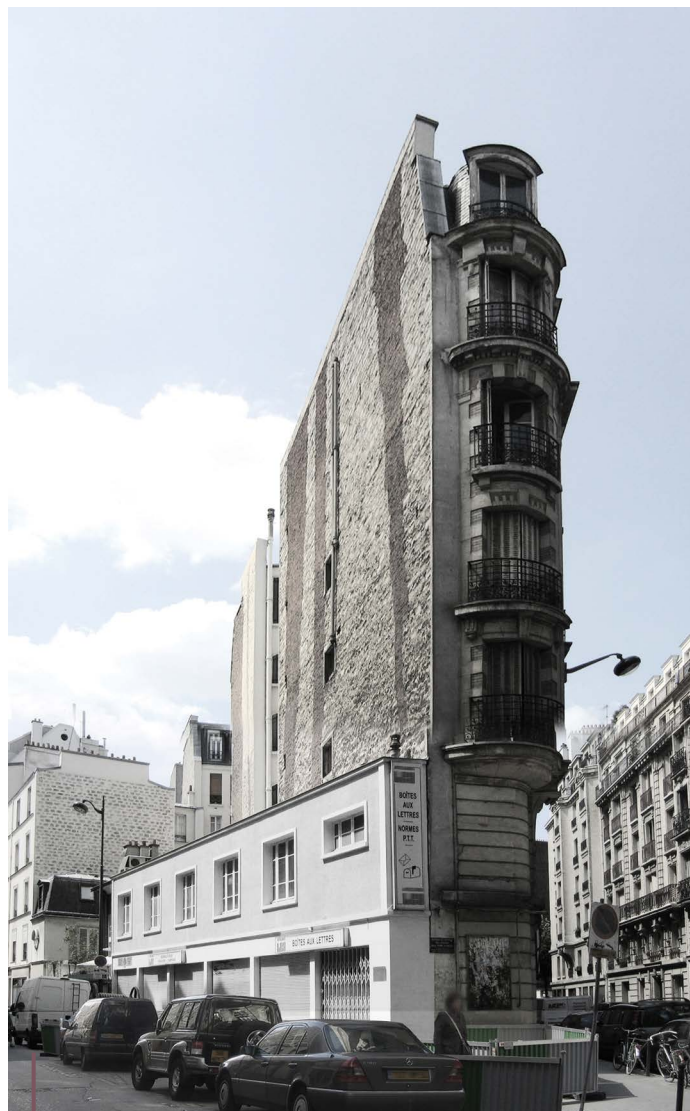
Avant et après surélévation d'un bâtiment bas occupé par un atelier pour créer deux logements, rue de la Sablière, Paris 14 e . Le projet améliore le traitement de l'angle de rue en venant s'adosser à un imposant pignon aveugle.
