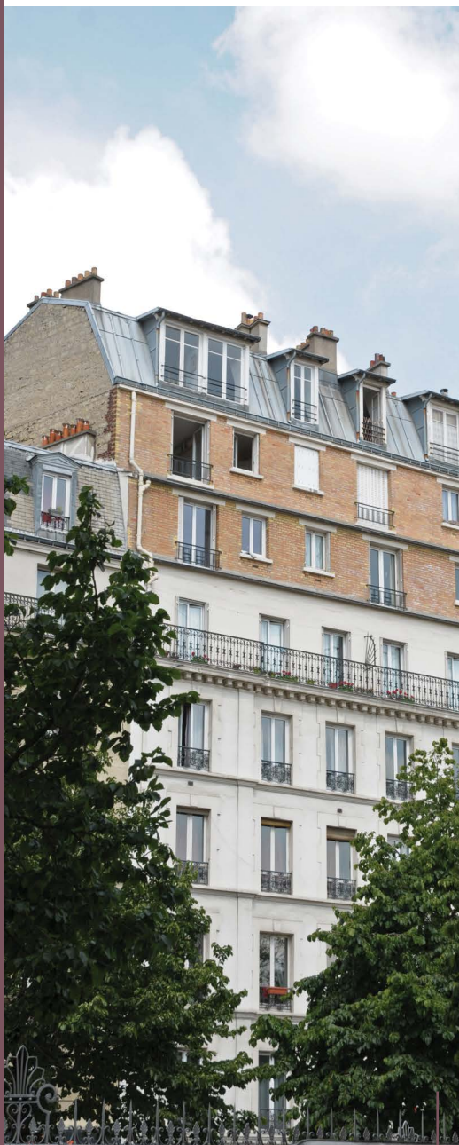
Surélévation datant des années 1930, Paris 12 e
