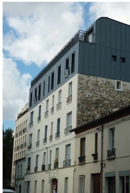
Surélévation d'un immeuble en copropriété avec modules préfabriqués en bois, Montreuil
