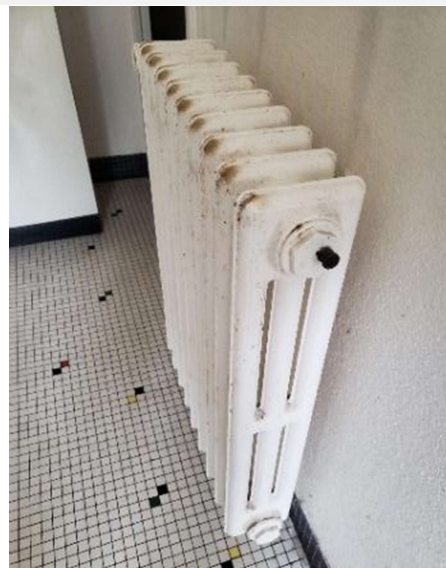
Radiateurs haute température
