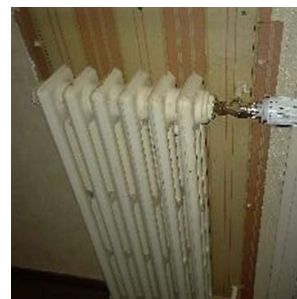
Pose de robinets thermostatiques ( chantier en cours )
