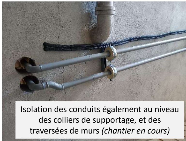
Isolation des conduits (classe 4) et des accessoires comme pompes de circulation, vannes... ( chantier en cours )
