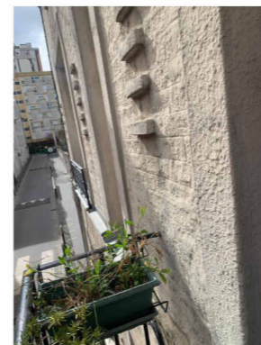
Façade rue - balcon R+1
