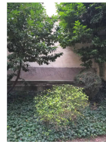
Façades Arrière (mur mitoyen parcelle N°3) - surépaisseur partie basse
