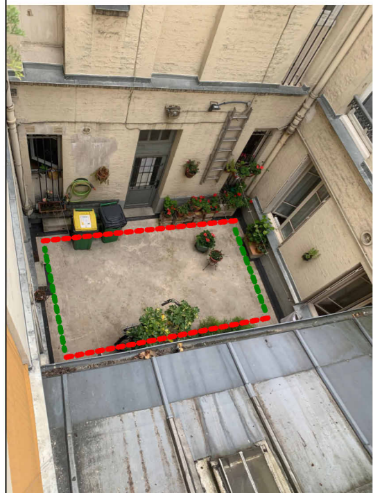
Photo cour - repérage traitement façades
