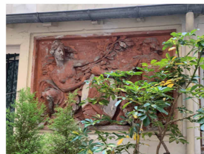
Fresque sur façade cour Est - à renover à l'identique
