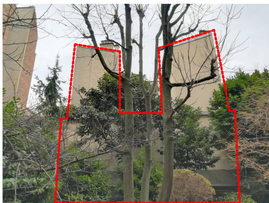
Façades Arrières (mur mitoyen avec parcelle N°3) - à isoler: ITE + Enduit = 27cm / 16cm (surépaisseur partie basse)
